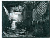
รูปที่ 1: อารมณ์เสียหายจากเหตุเพลิงไหม้ที่เกิดจากแบตเตอรี่ลิเทียมไอออน
